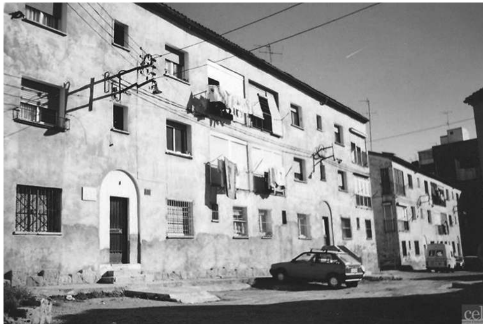
Els blocs de la FECSA, cap a l'any 1998 / CELH
