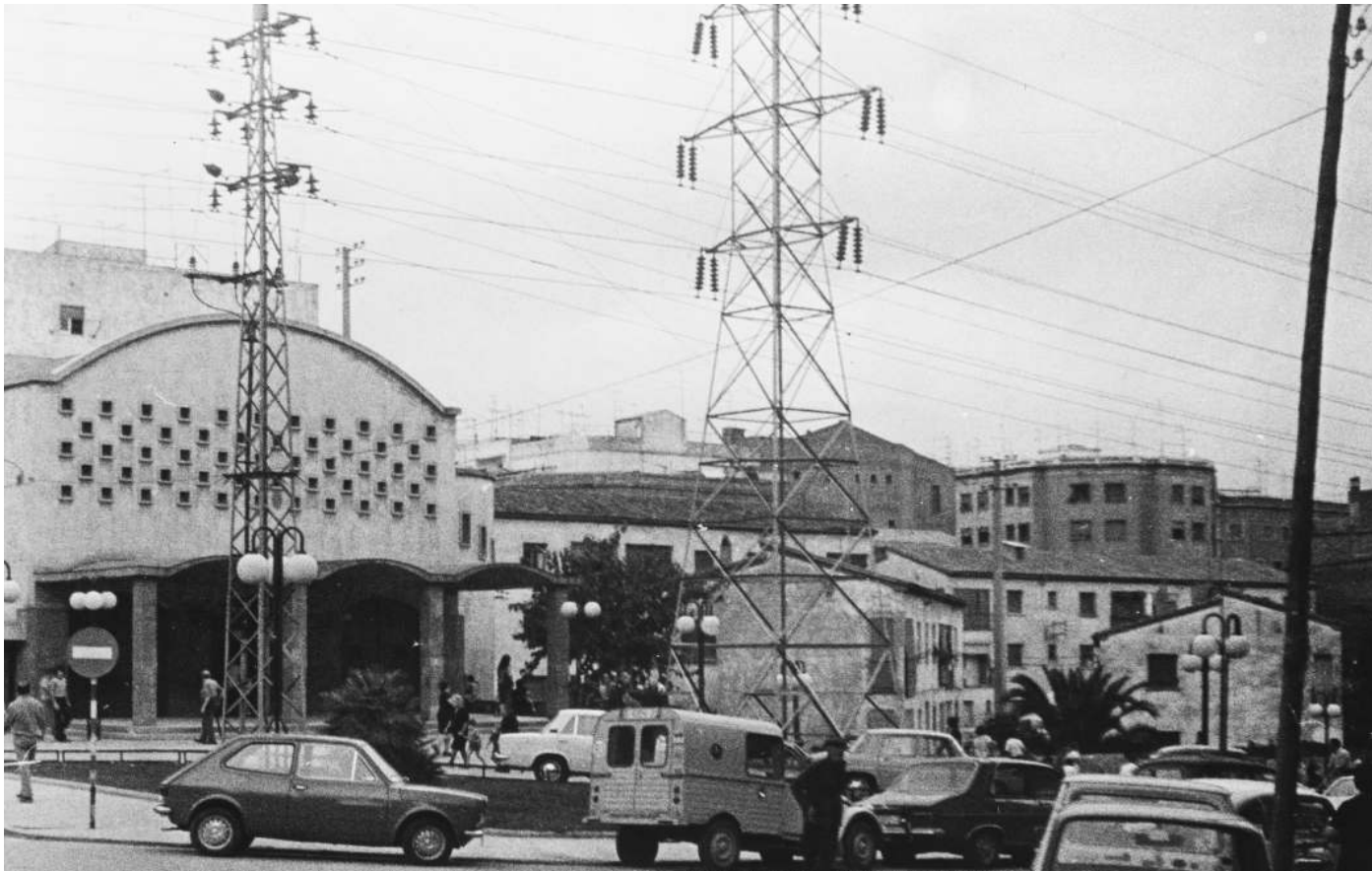
Façana principal i cases del voltant de la parròquia Mare de Déu de la Llum, ubicada al carrer de l'Enginyer Moncunill cantonada amb el carrer de la Primavera / AMHL 509 AF 0004248 /a.Autor desconegut/da /d.Centre d'Estudis de l'Hospitalet
