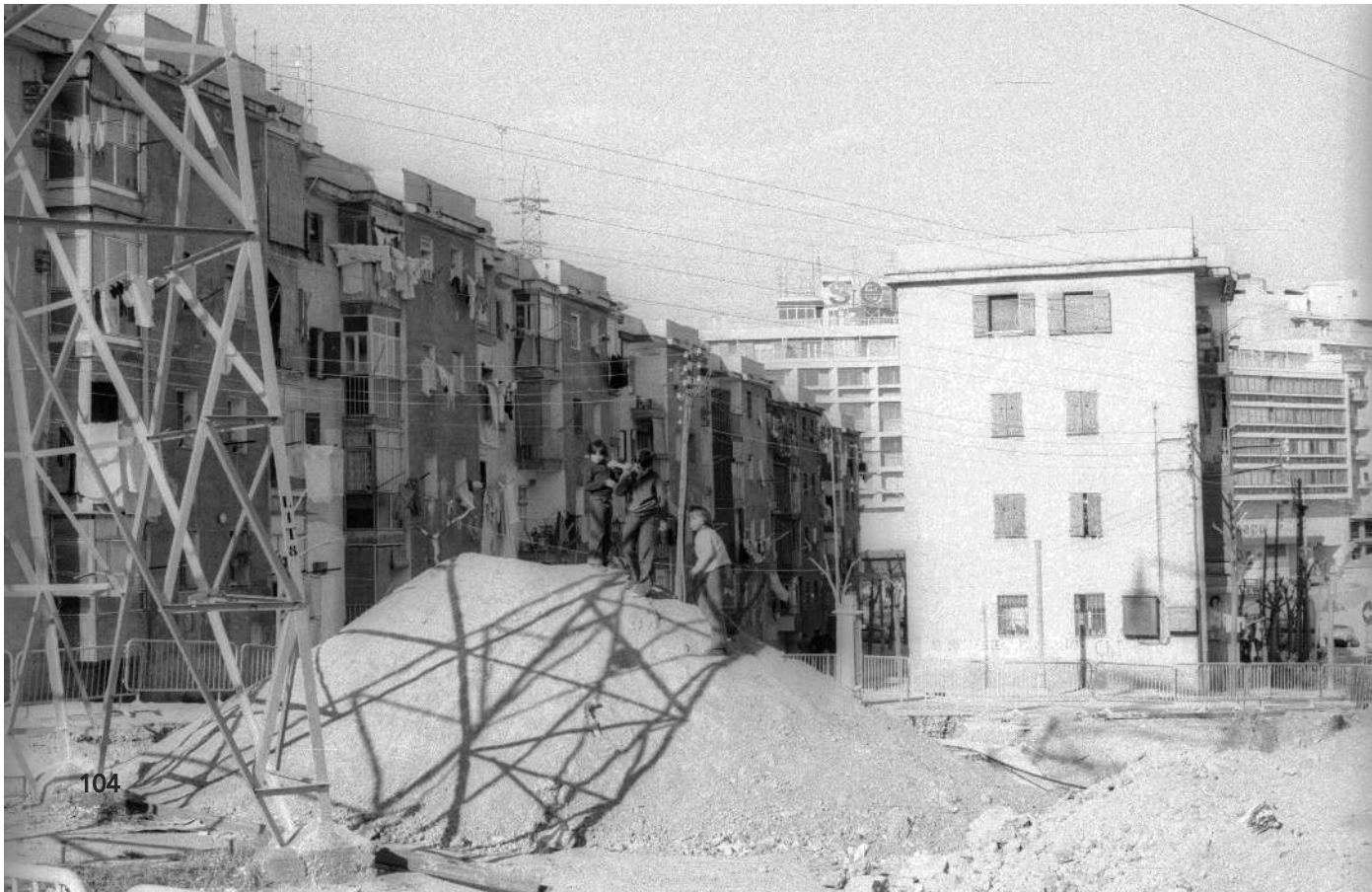
Vista dels blocs d'Onésimo Redondo, actualment Blocs La Florida. En primer terme, una torre elèctrica i els infants jugant al voltant / AMHL 860 AF 0004668 /a. Lucerón Navarro, Esteve /d. Esteve Lucerón Navarro
