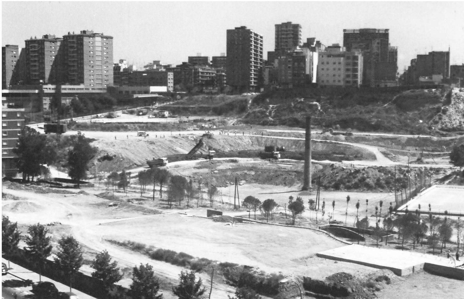
Vista del solar on abans hi havia la fàbrica La Cardoner i on es veuen les obres per a la construcció del parc de Les Planes /
