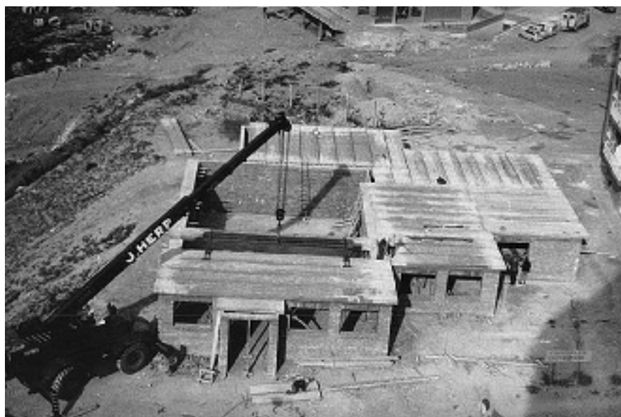
La Casa de la Reconciliació en construcció
