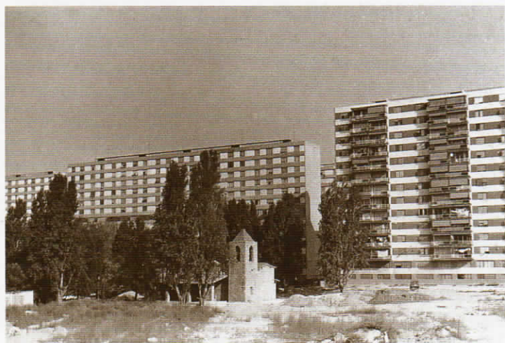
FOTO 95: L'ermita de Bellvitge. Canvi de funcions del territori: l'ermita, engolida pels blocs d'habitatges construïts des de mitjan dècada de 1960. La fecunda agricultura de la Marina estava a punt d'extingir-se. CEL'H.
