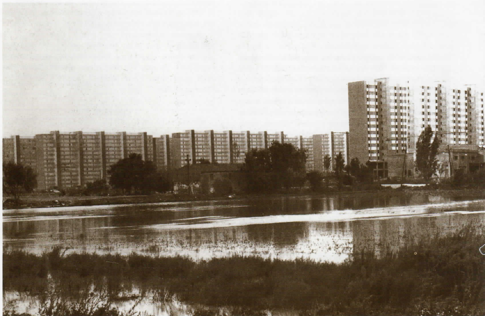
FOTO 94: Inundacions a Bellvitge. El barri de Bellvitge, construït a nivell de mar, a la Marina de l'Hospitalet. Amb habitatges als semisoterranis i amb un clavegueram insuficient, patirà les repetides inundacions de forma greu. Fons José Hernández.
