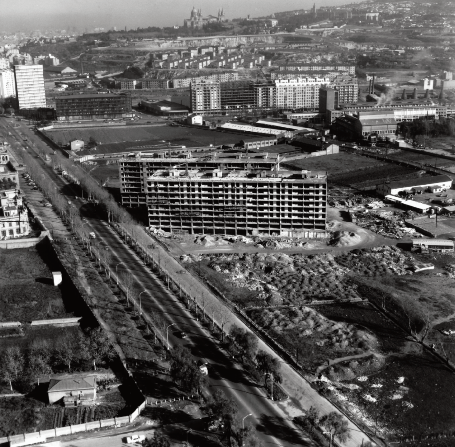
Els primers dos blocs en construcció, el desembre de 1965. Font: Fons TAF, Arxiu Nacional de Catalunya (ANC).
