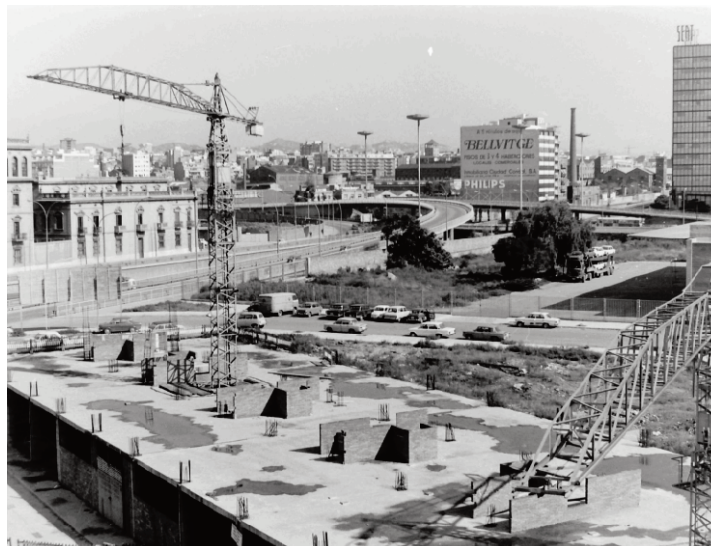
El Bloc D en construcció, (1970). Font: Arxiu AVIC.
