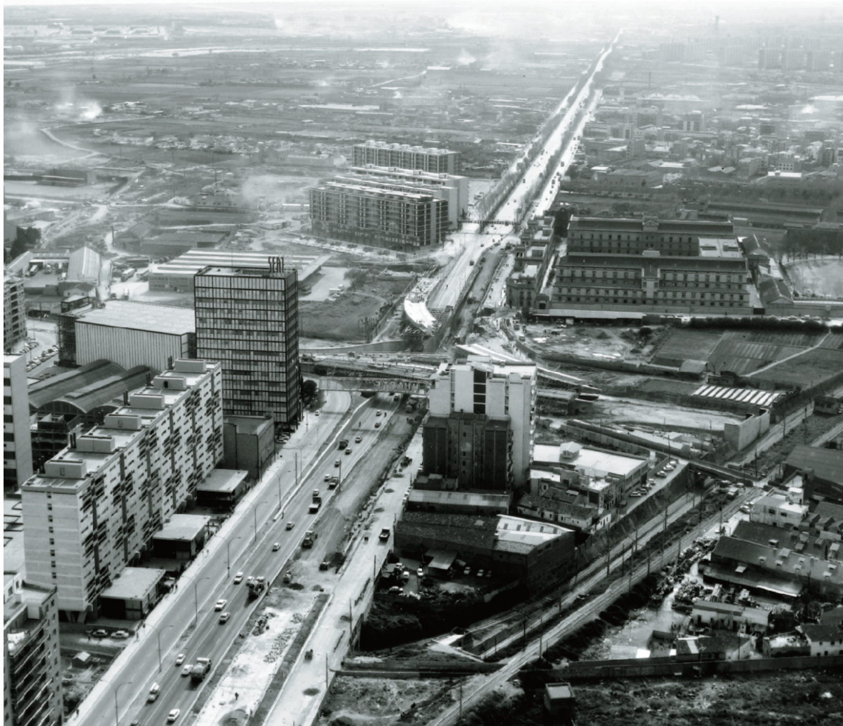
La Plaça Cerdà en obres i els primers quatre blocs de Granvia Sud ja construïts. Imatge presa el març de 1971.
