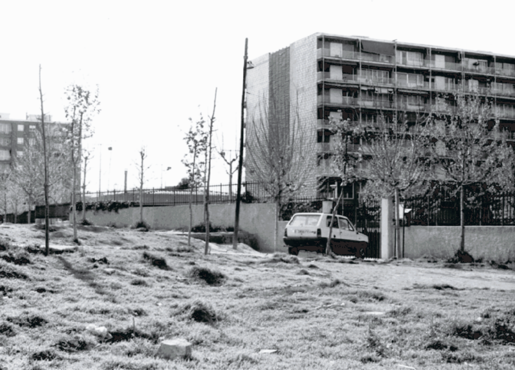
El Bloc F, poc després de la seva construcció. Podem veure que era el límit del barri. Font: Arxiu AVIC.”
