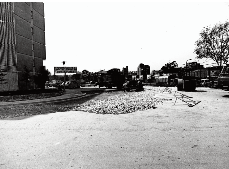
El Bloc F en construcció (1969). Font: Arxiu AVIC.
