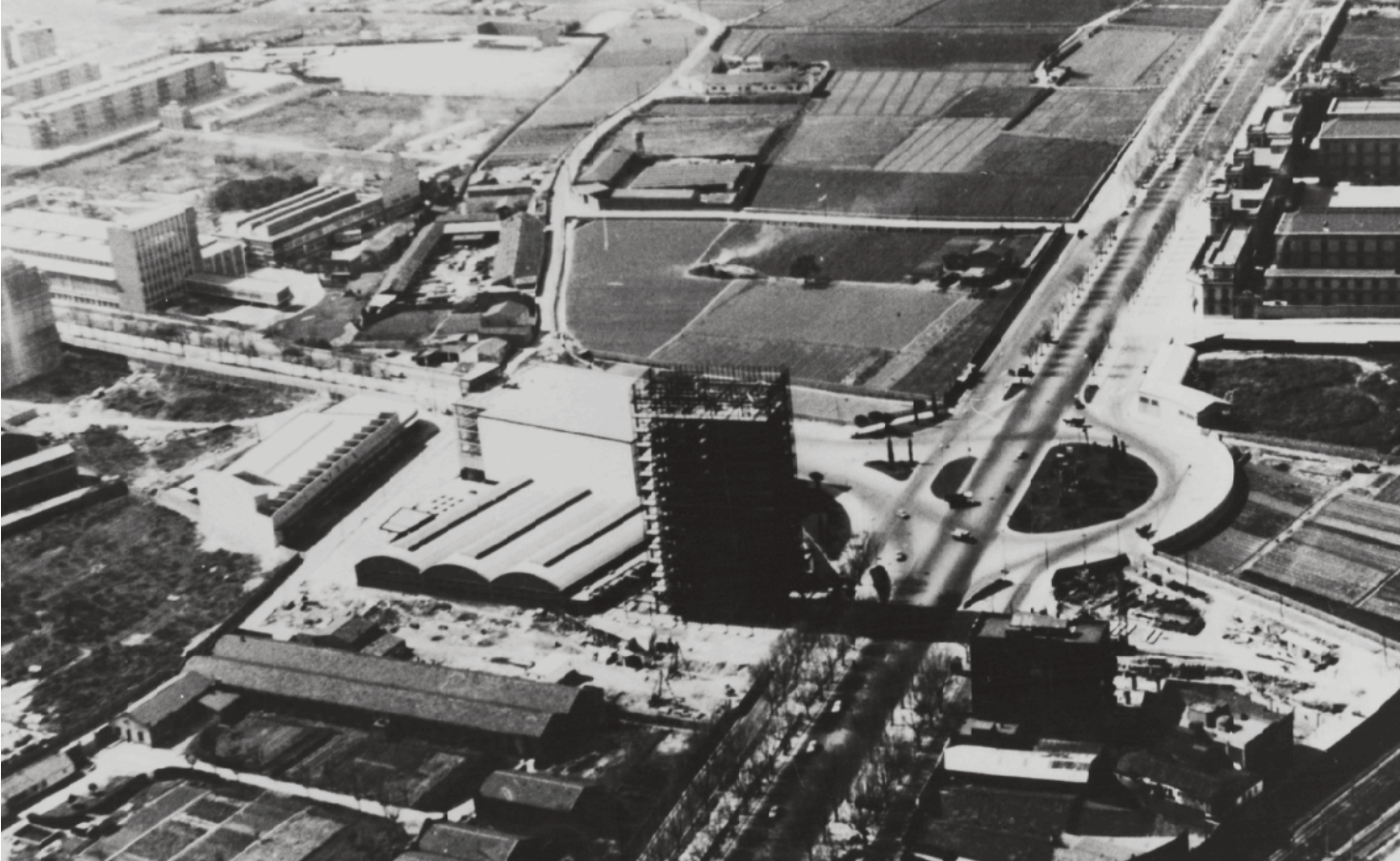
L'entorn de la plaça Cerdà vers 1958. A la part superior, d'esquerra a dreta: La Phillips i els habitatges de SEAT, les fàbriques Alpur i Renom, els terrenys de Balañá on es construirà el barri, la Granvia i la caserna de Lepant. Font: AVIC.
