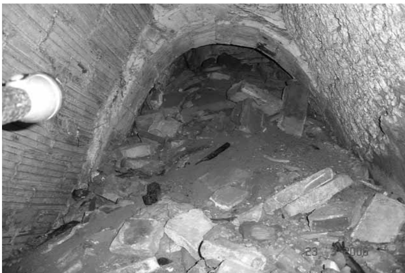
Foto 6. Accés cegat del refugi de Torre Barrina. Foto cedida per F. Xavier Menéndez.
